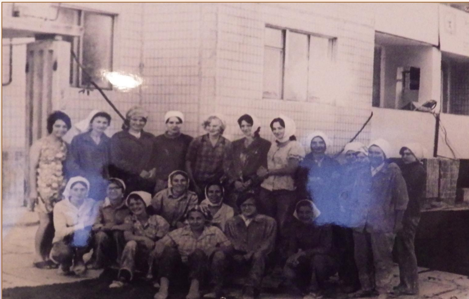
Перша бригада опоряджувальників Горб Ніни Трохимівни. Горб Н. Т. - перший ряд, друга зліва. Будинок на проспекті Перемоги 5, 1975 р.
